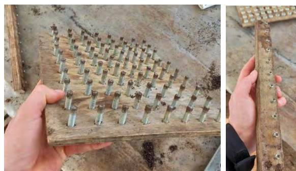
Plaque et latte cloutées pour creuser les cavités
